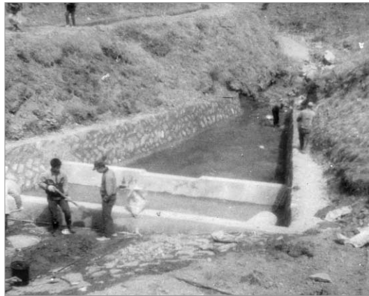
시흥보조정수장 취수설비 구조물 공사 모습
