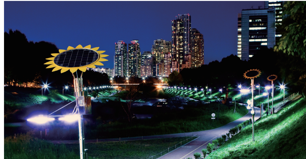
양재천에 설치된 태양광
