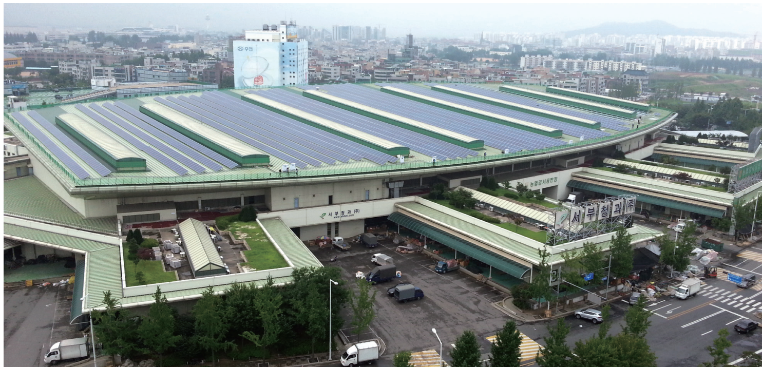
강서농수산물시장 옥상에 설치된 태양광
