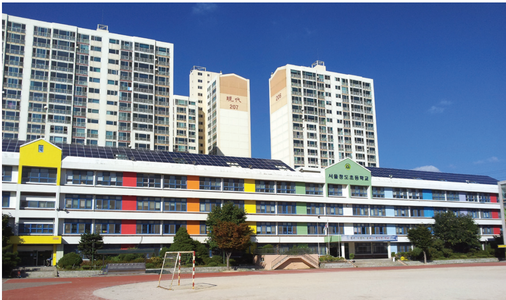
그림 10. 옥상에 설치된 태양광 사례
