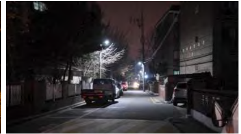
[그림 5-22] 보안등 및 공원등 개선 후(LED 50W) (2014.2촬영)
