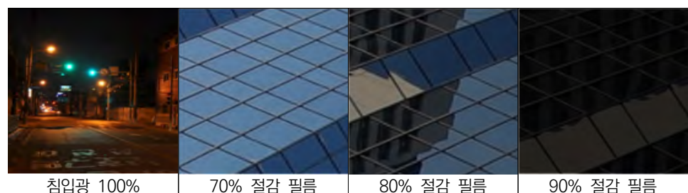
[그림 4-4] 차광필름 설치
