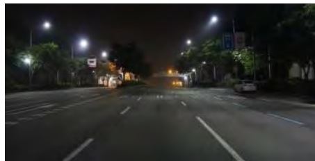
[그림 5-27] 개선사업 후 현장사진 (출처: 2013.11 촬영)
