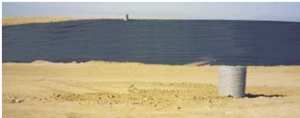
▲ 매립지 상부 차수막(HDPE)설치
