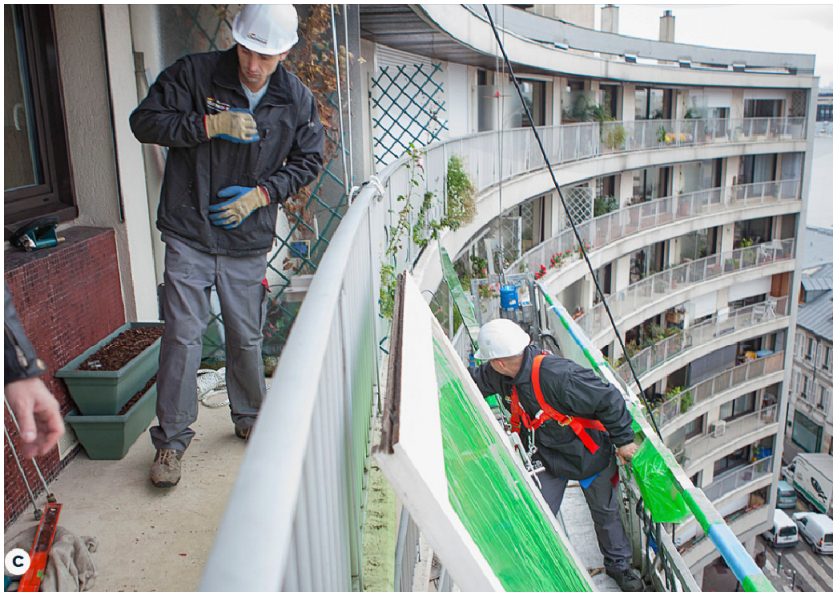
[그림] 파리지 공공임대주택 개선사업 현장
