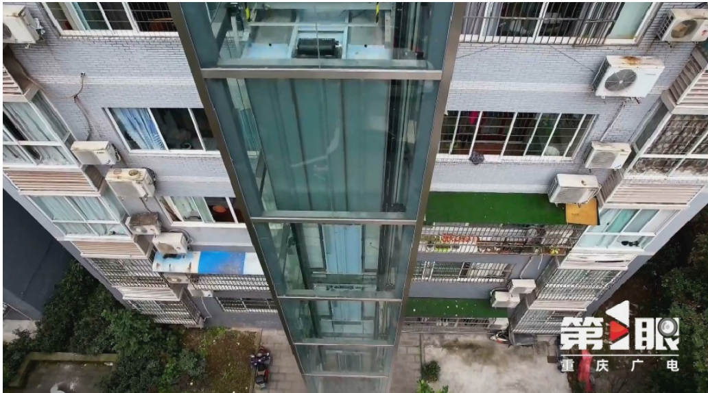
[그림] 구형 아파트에 새로 부설한 엘리베이터 (출처: 충칭라디오방송)
