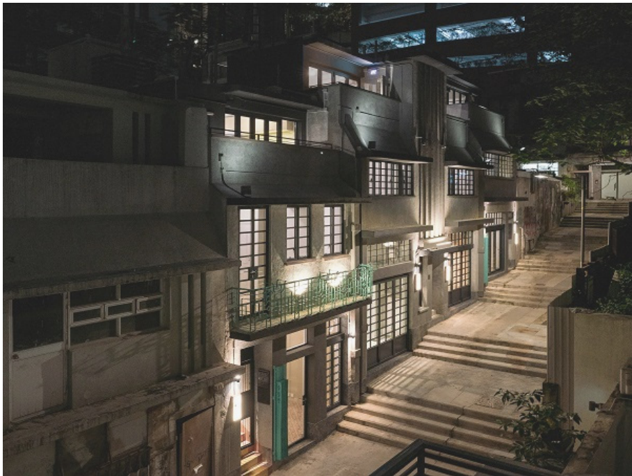
[그림] 노후 건축물을 리모델링하여 미관과 시설을 개선한 사례(4-10 Wa In Fong West)
