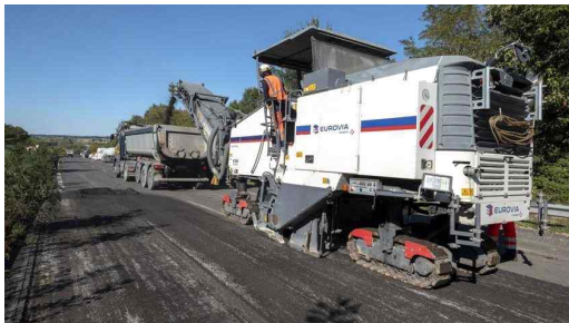
[그림 2] 기존도로 노면의 아스콘을 걷어내는 모습
