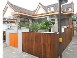
외관 변경공사 시공후
