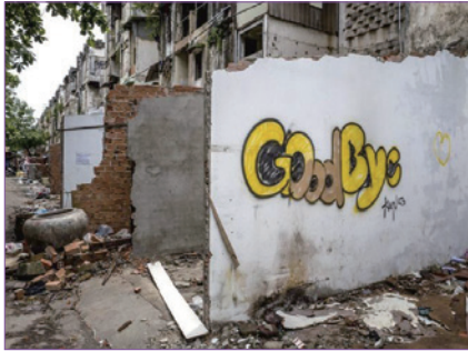
그림14 화이트빌딩 철거 및 착공식 현장
